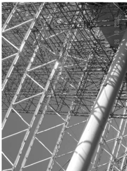
FOTO 2 -JOIST FORMADA POR 2 U LAMINADOS MONTADA
