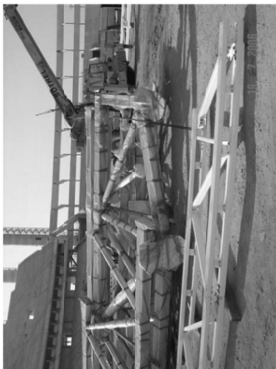
FOTO 1 -JOIST FORMADA POR 2 U LAMINADOS
