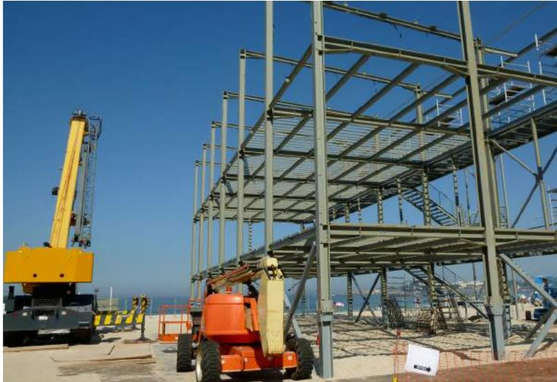
Figura 2.33: Exemplo de diferentes equipamentos mecânicos utilizado na montagem de estruturas em aço
