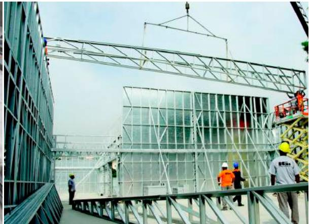
**Figura 2.27: Módulo de viga entregue pronto para montagem.**
