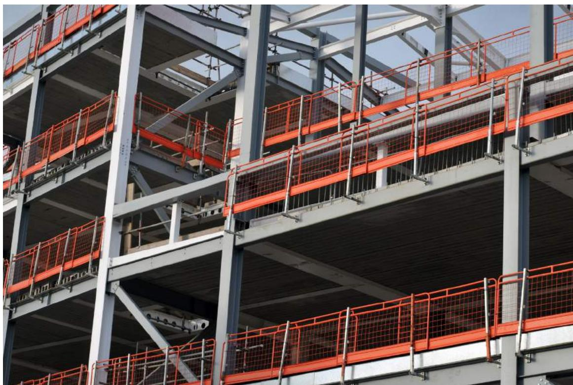
Figura 2.32: Exemplo de instalação de proteções coletivas
