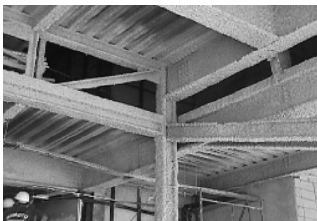
Foto 5.2 - Estrutura revestida por fibra projetada
