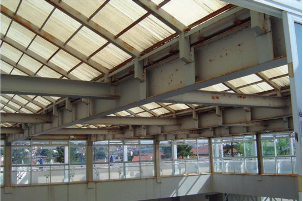
Figura 19: Situação em que o acesso para inspeção e reparos é muito dificultado. Não existe espaço para o trabalho com o ferramental de manutenção. Trata-se da cobertura de uma piscina aquecida.
