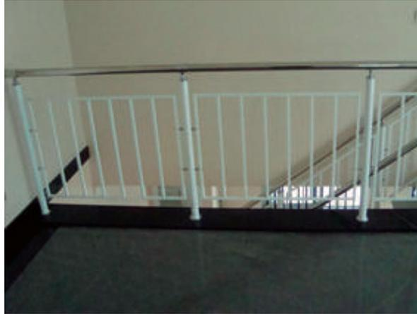
Figura 43: Eletrólitos são, de modo geral, ausentes em ambientes internos aerados e aquecidos. A combinação de ligas metálicas tais como aços inoxidáveis e aços carbono (pintado ou não) não envolvem riscos do aparecimento da corrosão galvânica.
