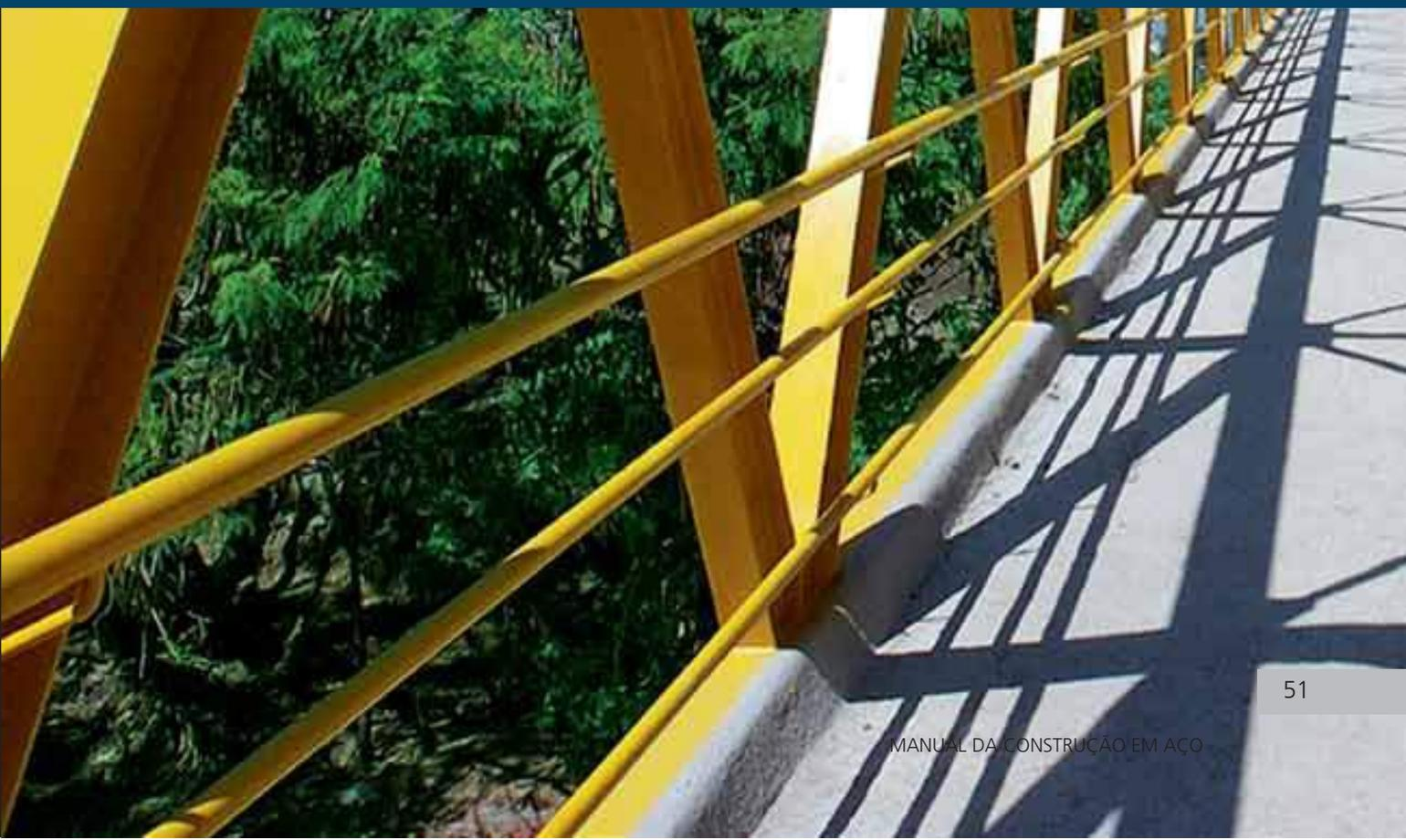
Estruturas de aço, expostas à atmosfera, sem proteção, estarão sujeiras à deterioração.
