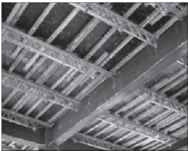
Figura 4.9 – Laje moldada no local
