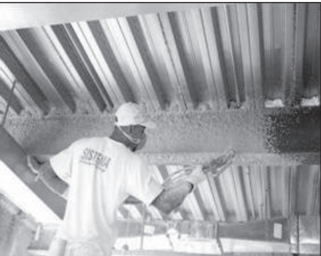
Figura 4.19 – Projeção de argamassa
